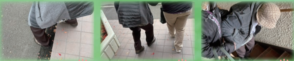
手すりのない段差
